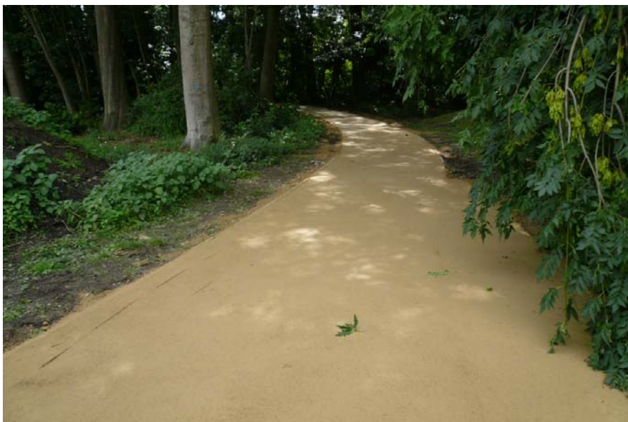
Gieten van Stabicol in kasteelpark Wallemote
