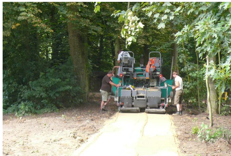
Gieten van Stabicol in kasteelpark Wallemote
